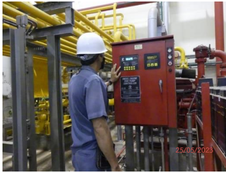
รูปที่ 2.2-27 การตรวจสอบ Fire Pump
